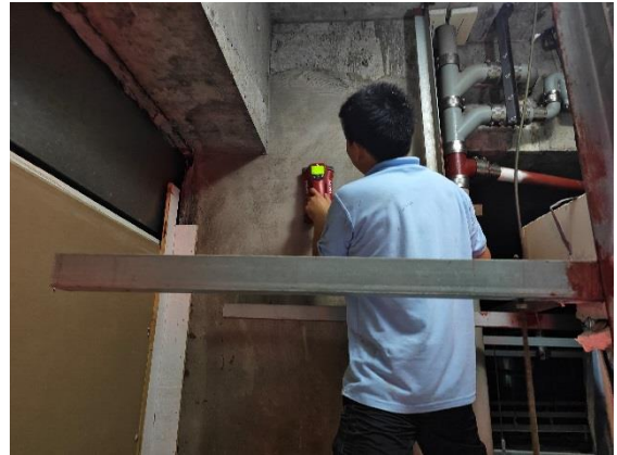
图 5.5 柱配筋钢筋探测
