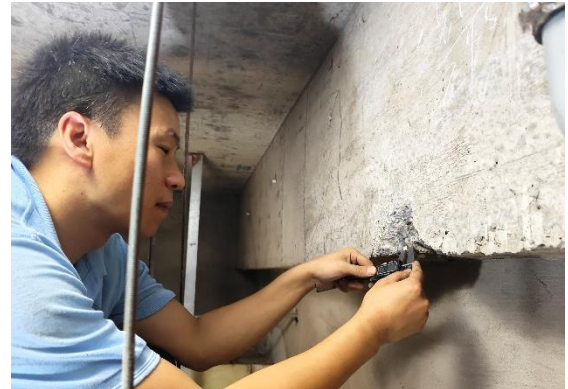
图 5.6-2 剔凿梁检测钢筋
