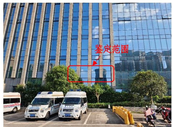
图 5-1 鉴定房屋外貌照片
