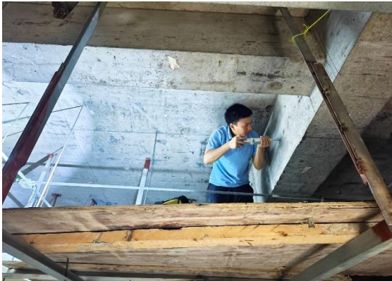
图 5.4 回弹法检测混凝土强度
